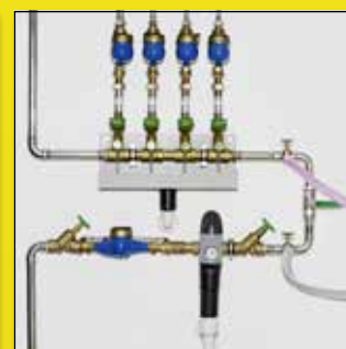
Flussaggio di impianti di acqua potabile (S/SL/SLW)
