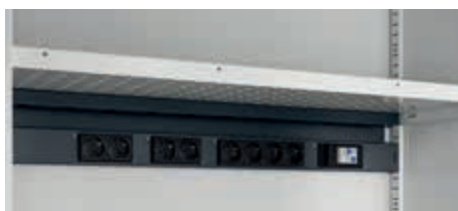
applicazione canaletta elettrica sulla parte inferiore del piano-pannello forato
